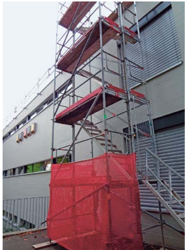
Bild 3 Sicherer Zugang über einen Treppenturm
