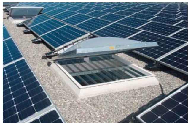
Bild 1 Oblicht, mit einem Gitter gegen Durchbruch gesichert
