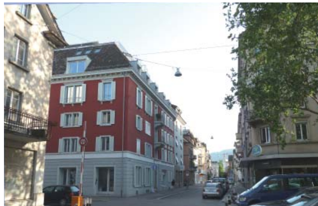
La casa di 10 appartamenti dopo l'ammodernamento
