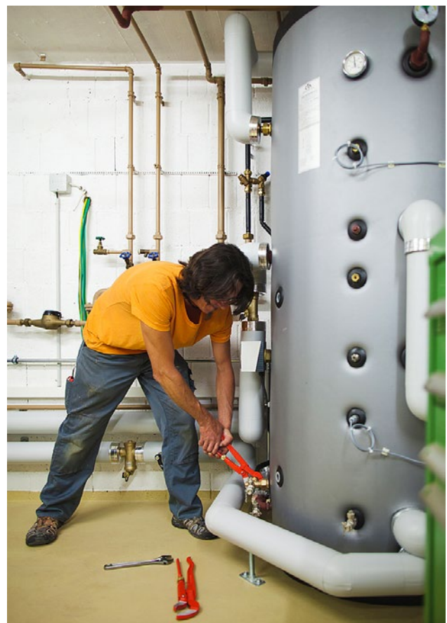
Dichtheitskontrolle am Speicher
