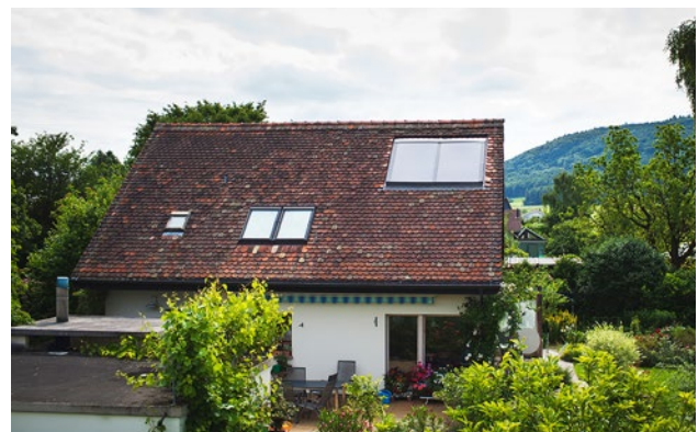
Sichtkontrolle der Kollektoren
