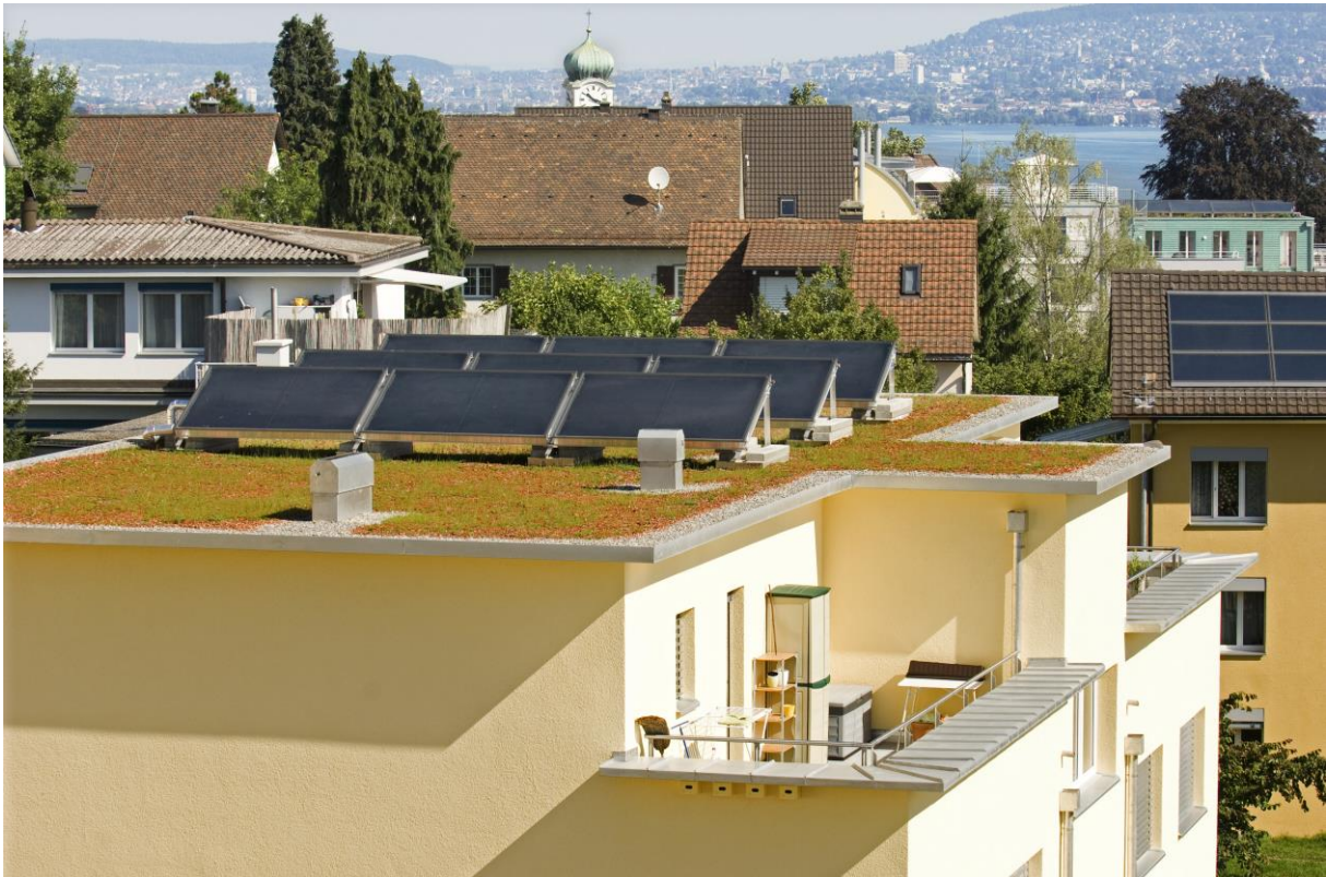
Bild#1: Solarwärme-Anlagen auf MFH, Thalwil
