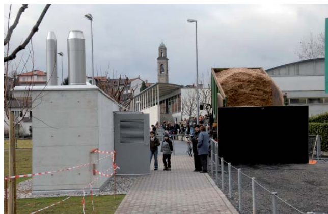
Holzsnitzelnachschub für den Wärmeverbund Coldrerio (TI)
