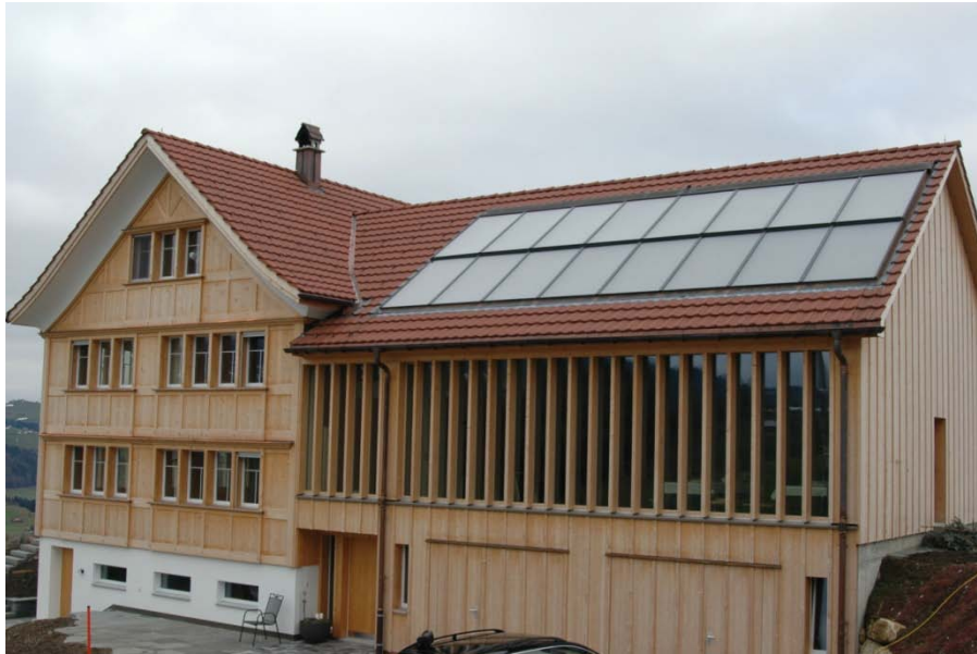
Frontansicht Gebäude mit Kollektoren
