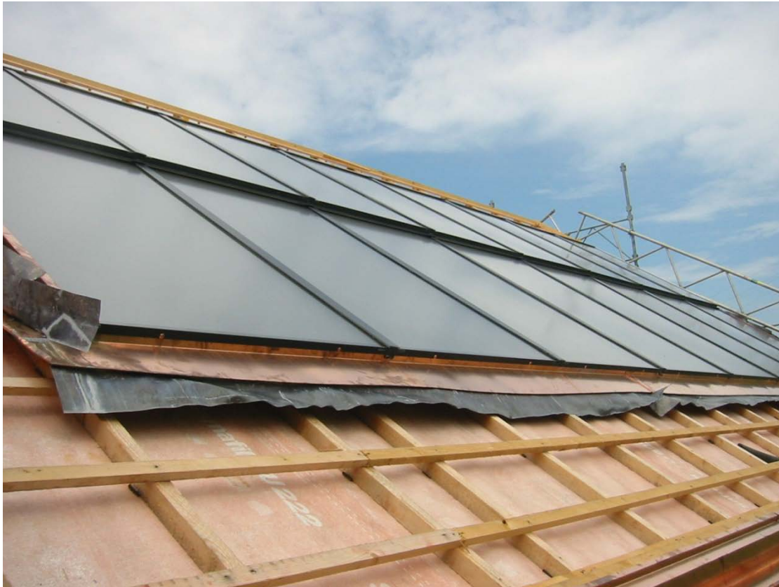
Montage des 2-reihigen Kollektorfeldes
