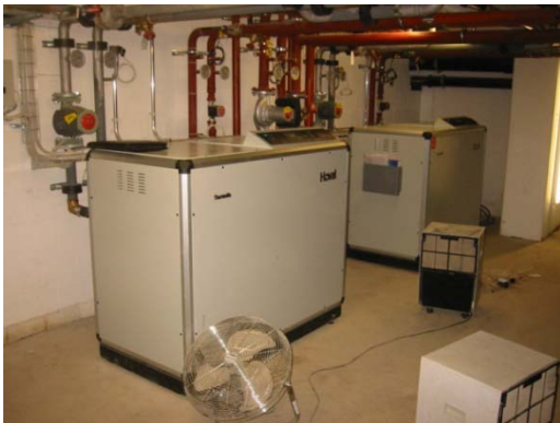
Erdsonden-Wärmepumpen
