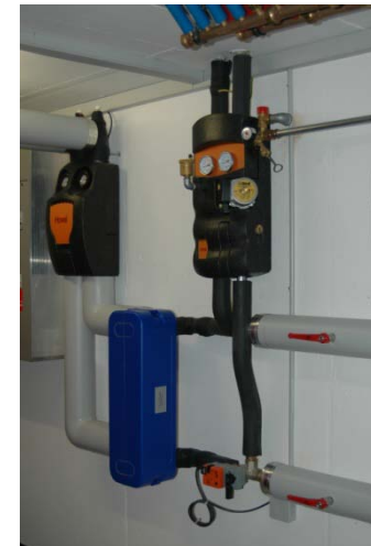
Solargruppe / Solarwärmetauscher
