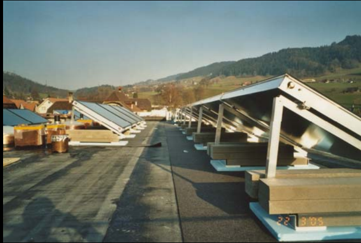
Wohnüberbauung Mattenpark Oberdiessbach - Montage Kollektoren
