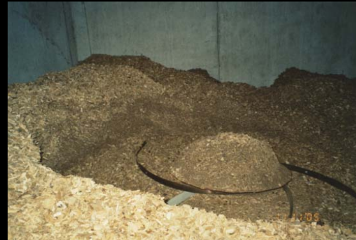
Wohnüberbauung Mattenpark Oberdiessbach - Federkernaustragung im Silo
