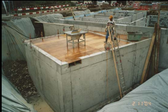
Wohnüberbauung Mattenpark Oberdiessbach - Rohbau Schnitzelsilo
