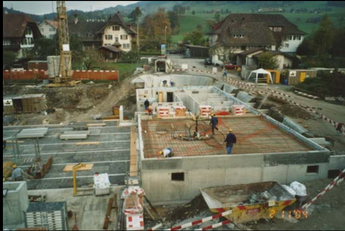
Wohnüberbauung Mattenpark Oberdiessbach - Rohbau Untergeschoss Haus 2
