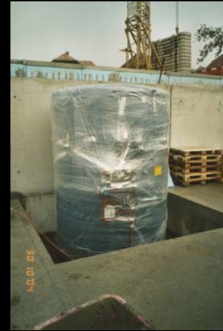
Wohnüberbauung Mattenpark Oberdiessbach - Einbau Wärmespeicher
