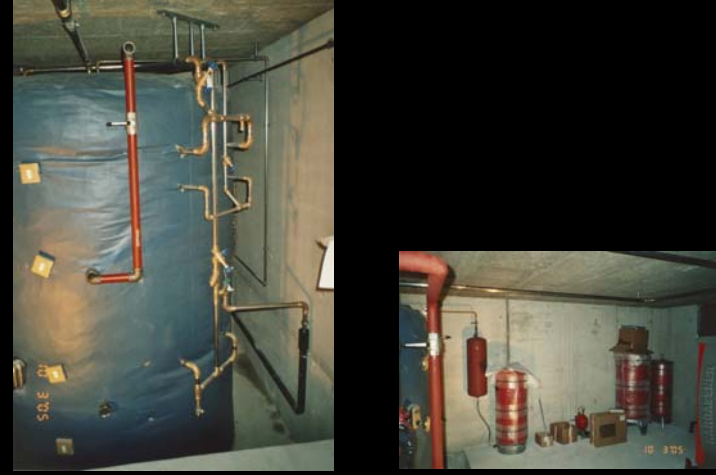
Wohnüberbauung Mattenpark Oberdiessbach - Aufbau Heizzentrale mit dem Wärmespeicher
