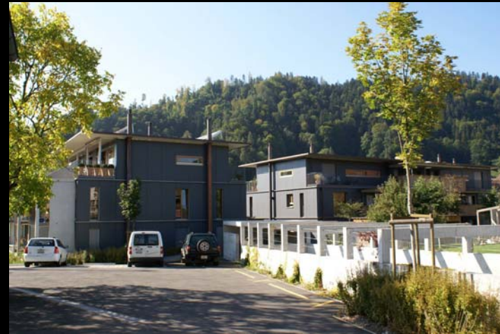
Wohnüberbauung Mattenpark Oberdiessbach - Zufahrt
