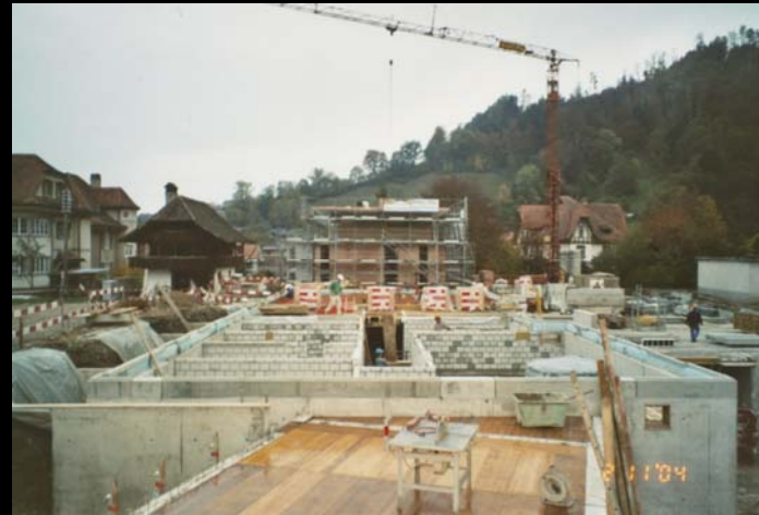
Wohnüberbauung Mattenpark Oberdiessbach - Gesamtansicht Silo und Heizzentrale
