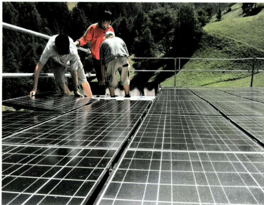
Jugendliche aus Deutschland, Frankreich, Russland und der Schweiz montieren im Rahmen einer Greenpeace-Woche in Feldis auf dem Dach eines Stalles eine 300 m 2 grosse Photovoltaik-Anlage. (Bild: zvg)
