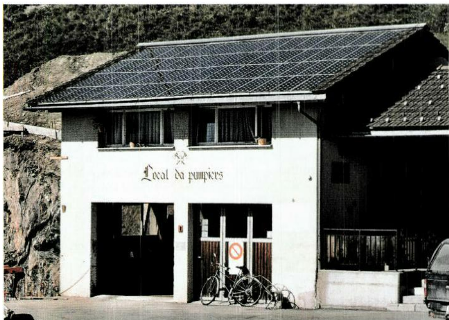
Solarstromanlage auf Feuerwehrhaus in Feldis/Veulden.
