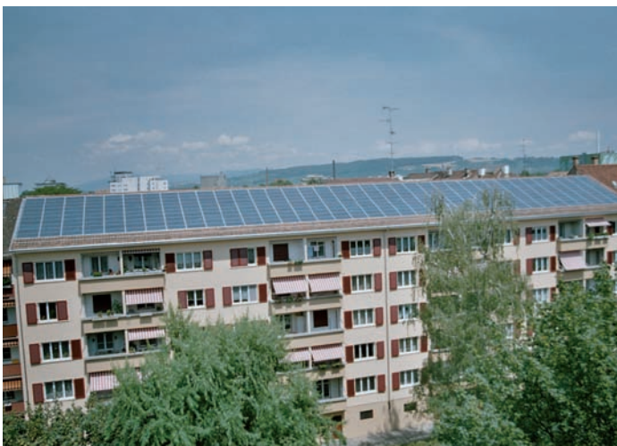
Solarstromanlage auf Mehrfamilienhaus in Zürich (Enecolo AG)
