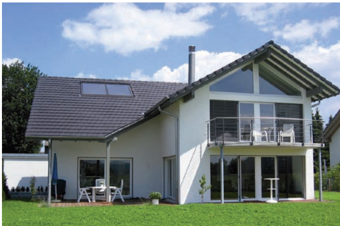
Solare Warmwasseranlage auf Einfamilienhaus (Conergy AG)
