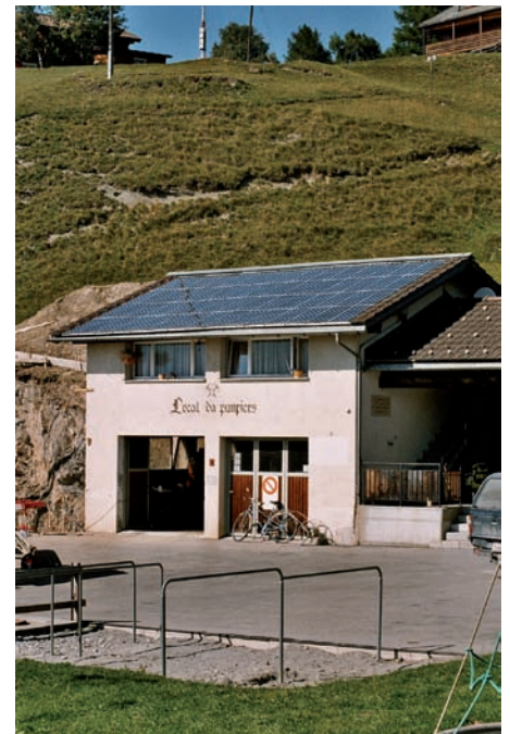
Bild 4: Solarstromanlage auf Feuerwehrhaus in Feldis/Veulden (Solaragentur)
