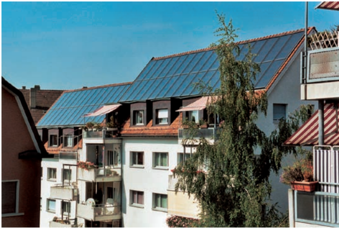
Solare Vorwärmung auf Mehrfamilienhäusern der Genossenschaft Freiblick in Zürich (Soltop AG)
