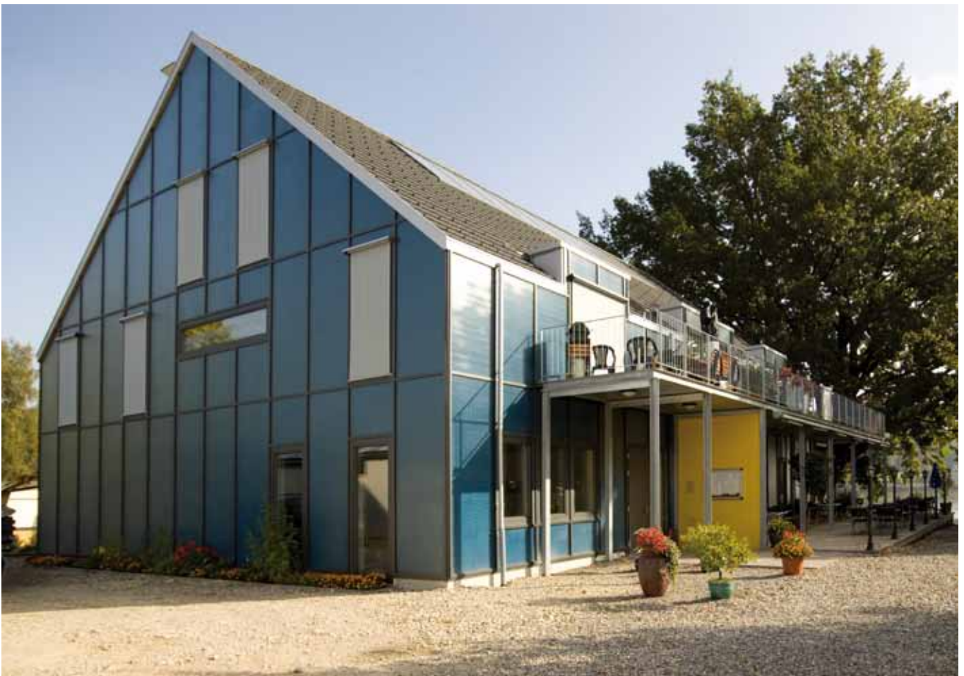
Restaurant Seerose am Moossee nach Minergie-P-Standard. Wärmegewinnung mit Solarfassade Lucido®. © Robert Bachofner. Ristorante Seerose sul Moossee secondo gli standard Minergie-P. Produzione di calore con facciata solare Lucido®. © Robert Bachofner.
