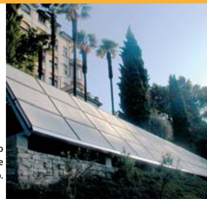
L'impianto solare della Casa di Cura Montesano a Orselina fa risparmiare ogni anno oltre 16'000 litri di olio da riscaldamento.
