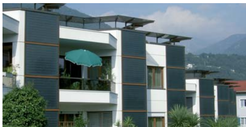
Casa a schiera a Minusio: dal 1978 100 m² di collettori integrati nelle facciate.
