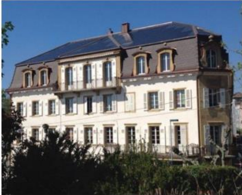
Hôtel des Associations, Neuchâtel, inventario ISOS con obiettivo di salvaguardia A. Fotovoltaico integrato 28 kWp.
