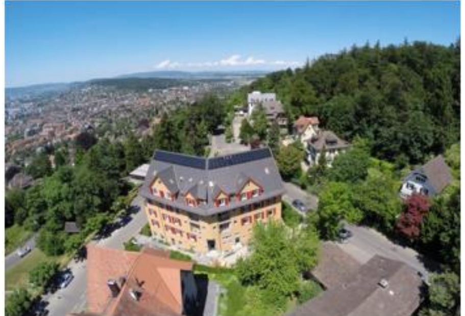
Justinushaus, Zurigo, monumento storico (anno di costruzione 1907). Impianto solare termico.
