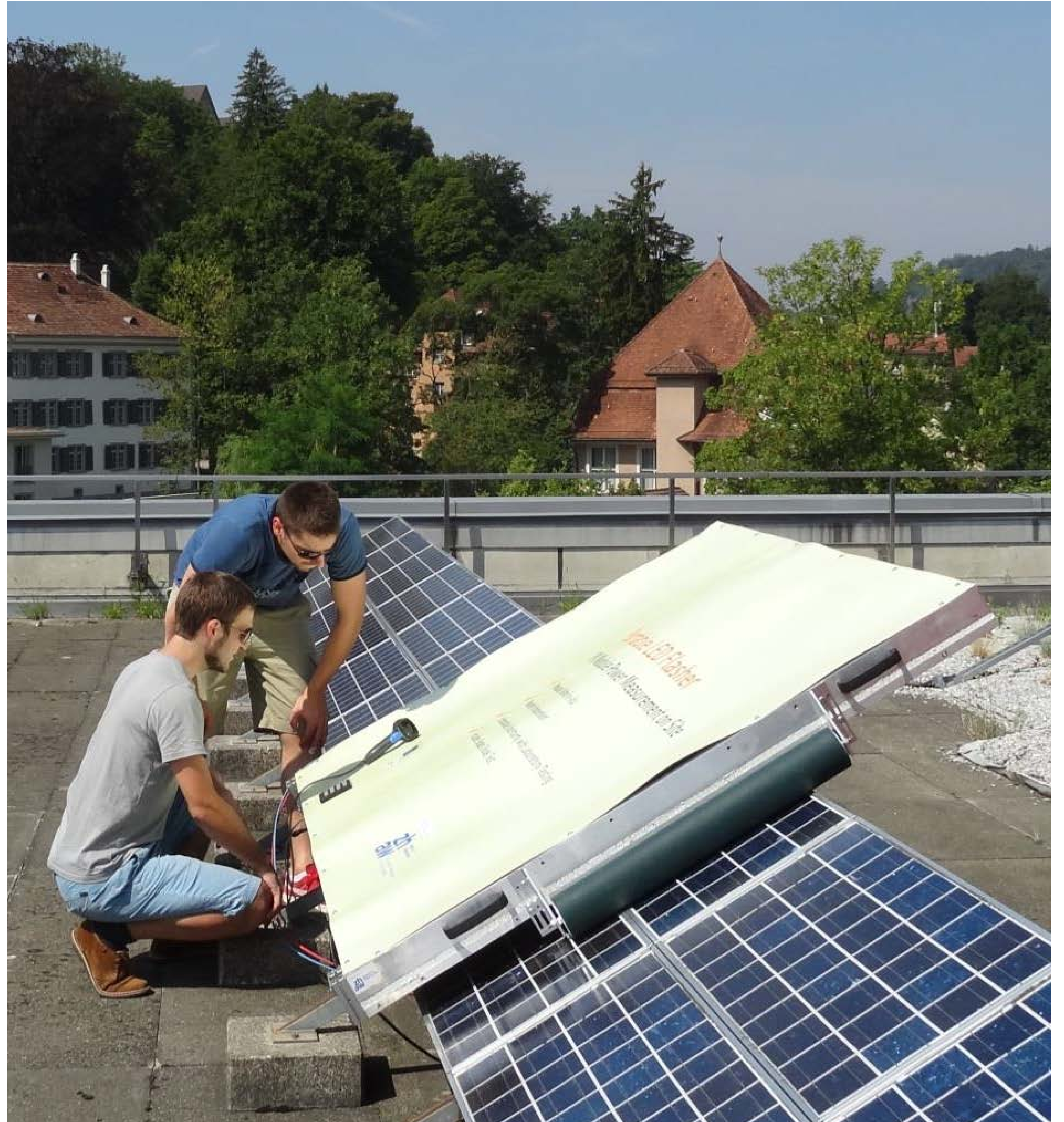
Abbildung 1: Portable LED Flasher im Einsatz auf einem Flachdach (ZHAW)
