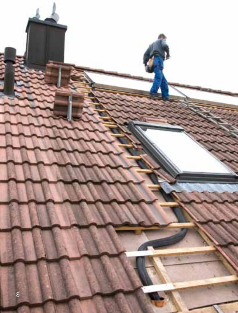
15h15 La conduite est posée professionnellement.
