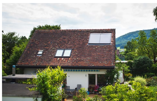
Controllo visivo dei collettori
