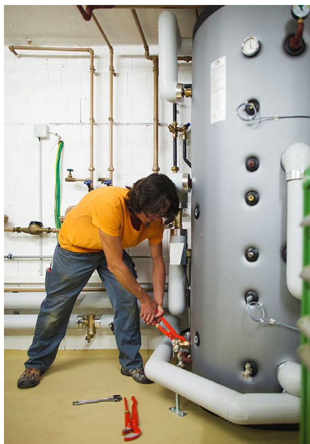
Controllo dell'ermeticità sull'accumulatore
