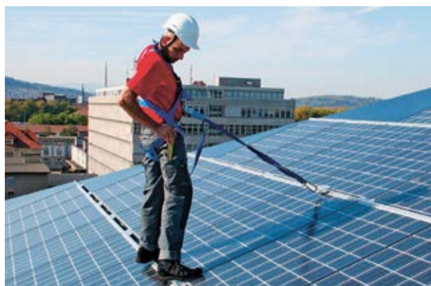
Bild 12 Anschlageinrichtung, in Solaranlage integriert
