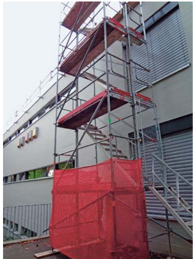
Bild 3 Sicherer Zugang über einen Treppenturm
