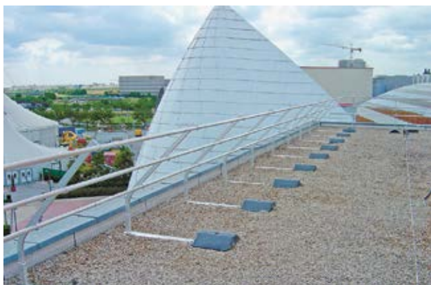
Bild 6 Seitenschutz ohne Dachhautdurchdringung – temporär und permanent einsetzbar
