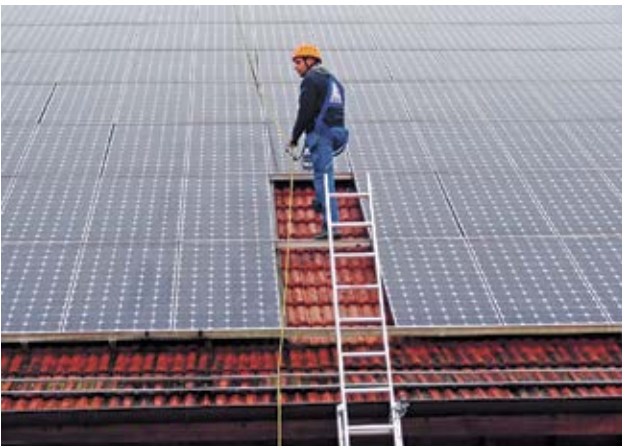
Bild 18 Überwurfseil, mit einem Mitläufer gesichert
