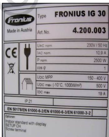
Bild 3: Typenschild eines Wechselrichters
