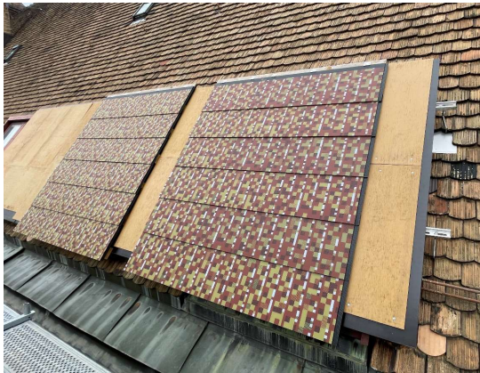
Entwürfe als Mockup mit funktionierenden PV-Modulen
