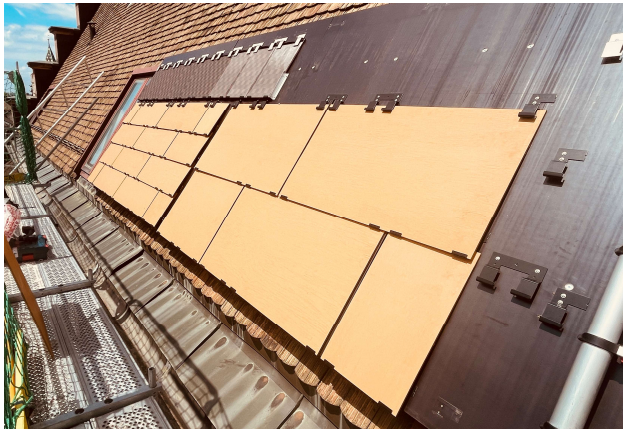
Unifarbene PV-Module nach Farbabgleich mit Dach
