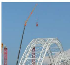
Bild 1: Eine sichere Alternative zu einer 85 m Kletterpartie zum Fachwerkknotenpunkt des Bogentragwerks ist der Ein- und Ausstieg aus einem Kran-Arbeitskorb (→ länderspezifische Regelungen beachten!)
