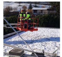
Bild 2: Erreichen eines hochgelegenen Arbeitsplatzes mittels Hubarbeitsbühne
