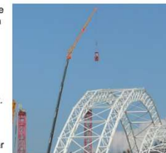
Bild 1: Eine sichere Alternative zu einer 85 m Kletterpartie zum Fachwerknutenpunkt des Bogentragwerks ist der Ein- und Ausstieg aus einem Kran-Arbeitskorb. (→ länderspezifische Regelungen beachten!)
