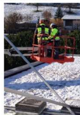
Bild 2: Erreichen eines hochgelegenen Arbeitsplatzes mittels Hubarbeitsbühne
