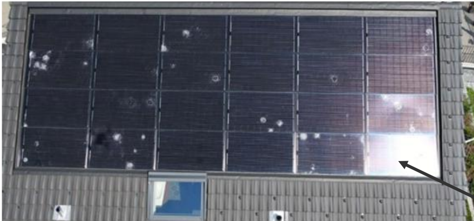
Abbildung 5 Drohnenaufnahme eines Hausdachs mit Hagelschäden, Bildrecht: Energie Netzwerk, Heinz Simmler
