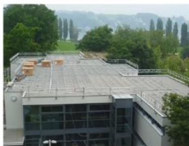
Protezione laterale continua provvisoria su un tetto piano.
