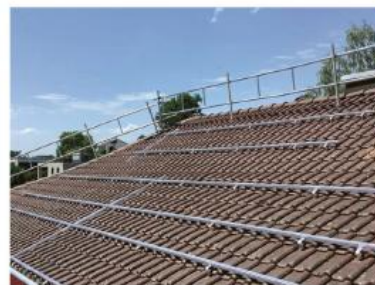
Protezione laterale continua su un tetto inclinato - anche nella zona di colmo.
