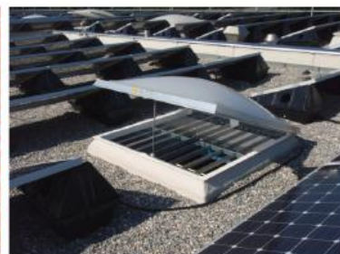
Lavoro su base con protezione collettiva fissa permanente (griglia). Questa deve essere installata prima del montaggio dell'impianto solar.
