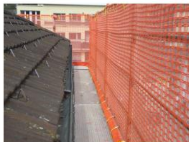
Ponte da lattoniere con ponteggio di protezione da capriblato con un'inclinazione del tetto superiore a 10°.
