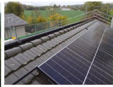
Protezione articolata nel bordo del tetto per il montaggio - punti di fissaggio permanenti per la manutenzione sicura su un tetto inclinato.
