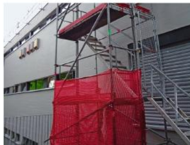
Accesso sicuro tramite un corso scala.
