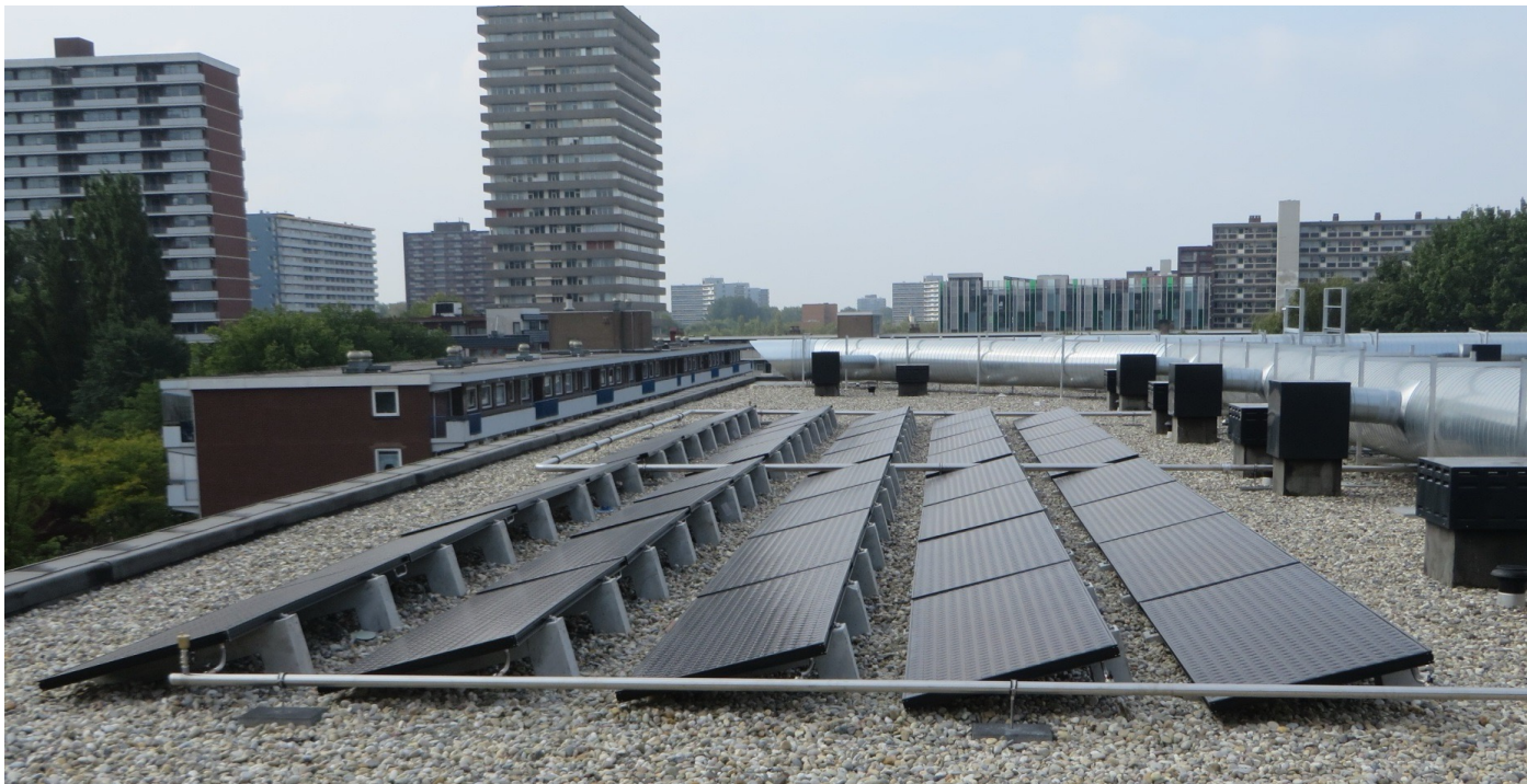
MFW «Pauwmolen» in Holland: 160 m 2 AS Kollektoren zur Regeneration des Grundwassers & Brauchwasservorwärmung
