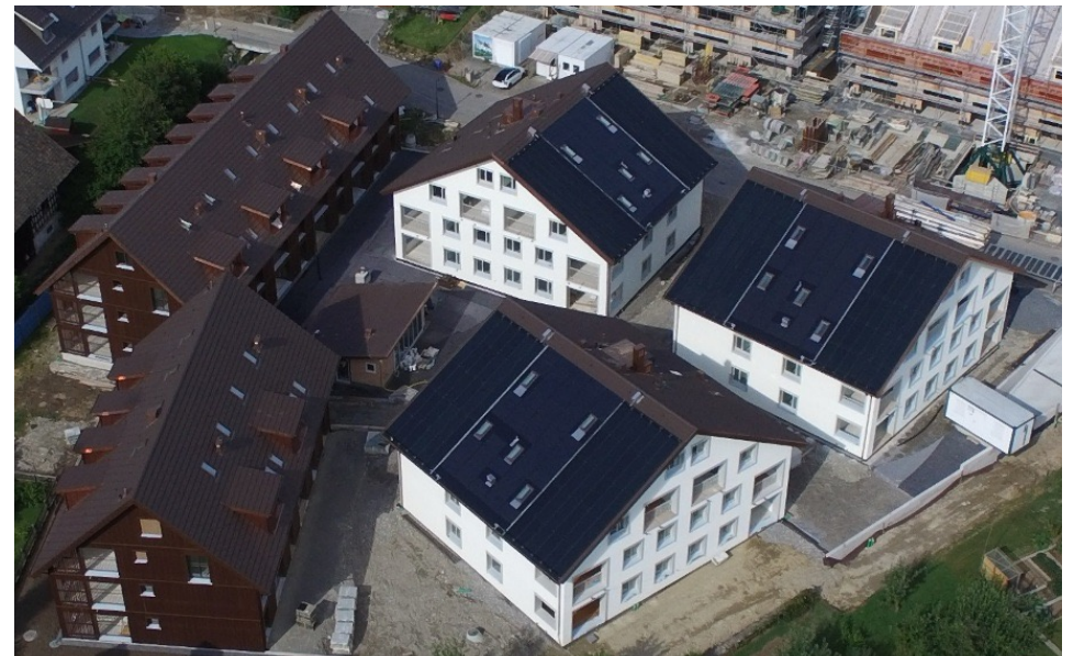
Mettmenstetten, Maettmi50+, 3 x 125m 2 Solardach AS kombiniert mit PV Kopplung solar + WP + Erdsonden; Konzept: HETAG A. Huber
