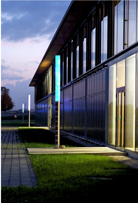
CeRn in Bursin erstes Minergie ECO Amtsgebäude der CH: Solarfassade 750m 2 , Schweizer Solarpreis 2007
