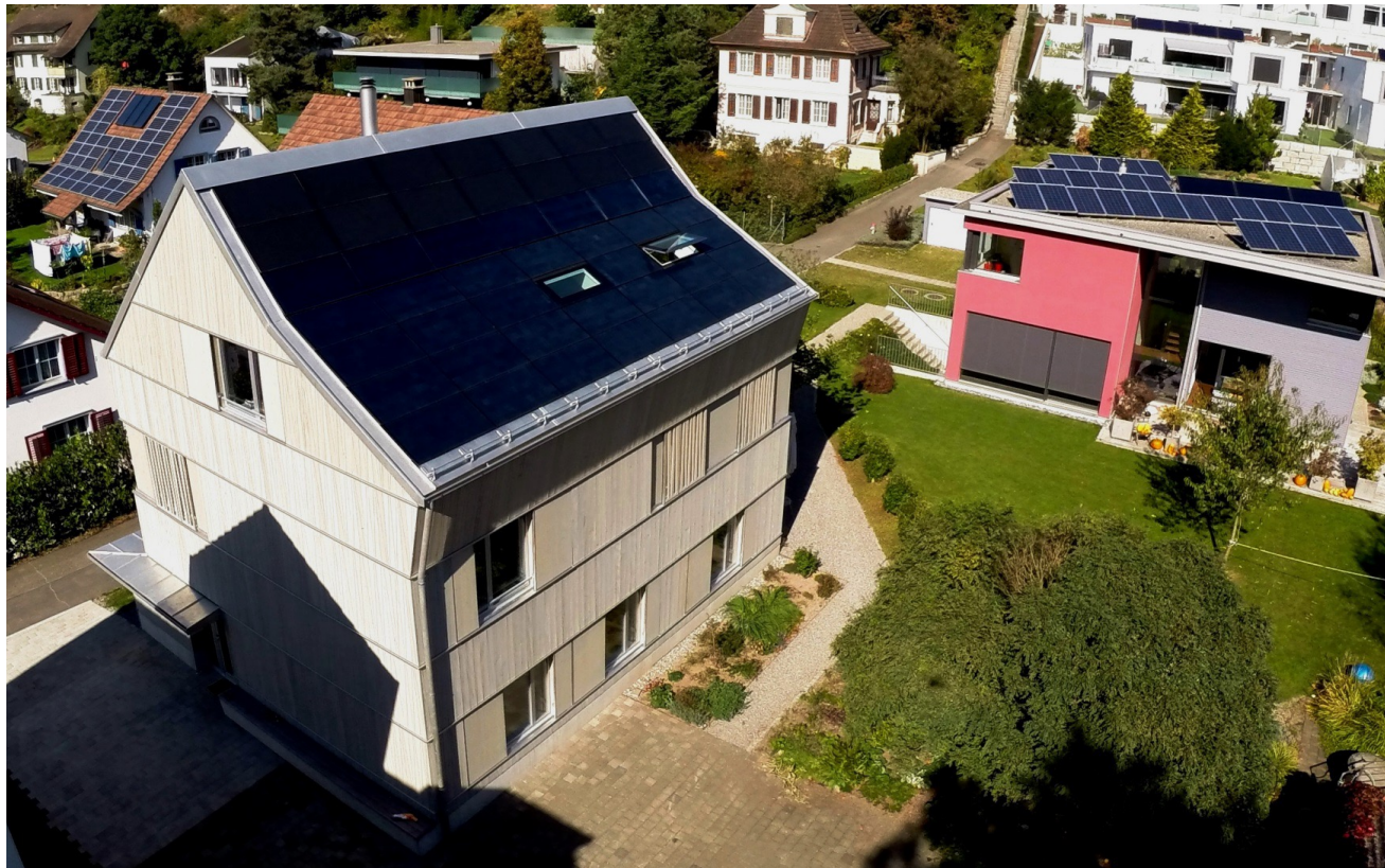
Kombidach Solarthermie + PV mit SOLRIF System (Schweizer) Haus Creti in Glattfelden, Architekturpreis 2014
