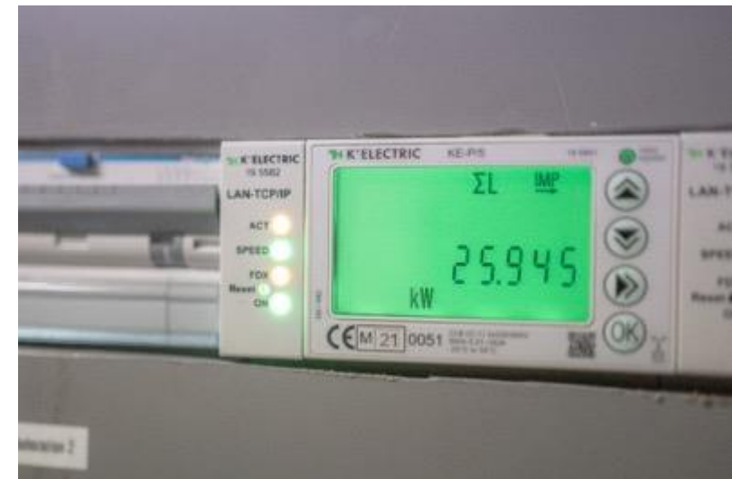
Contatore di energia con modulo di comunicazione -a sinistra- con 4 led.
