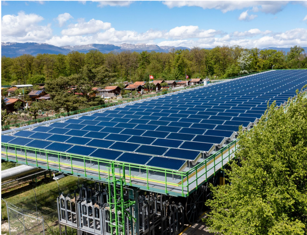
784 m 2 Vakuum-Flachkollektoren in Genf, © TVP
