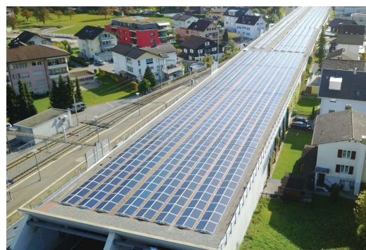
Couverture de tronçons d'autoroute - Stansstad (NW) - 840 kWp
