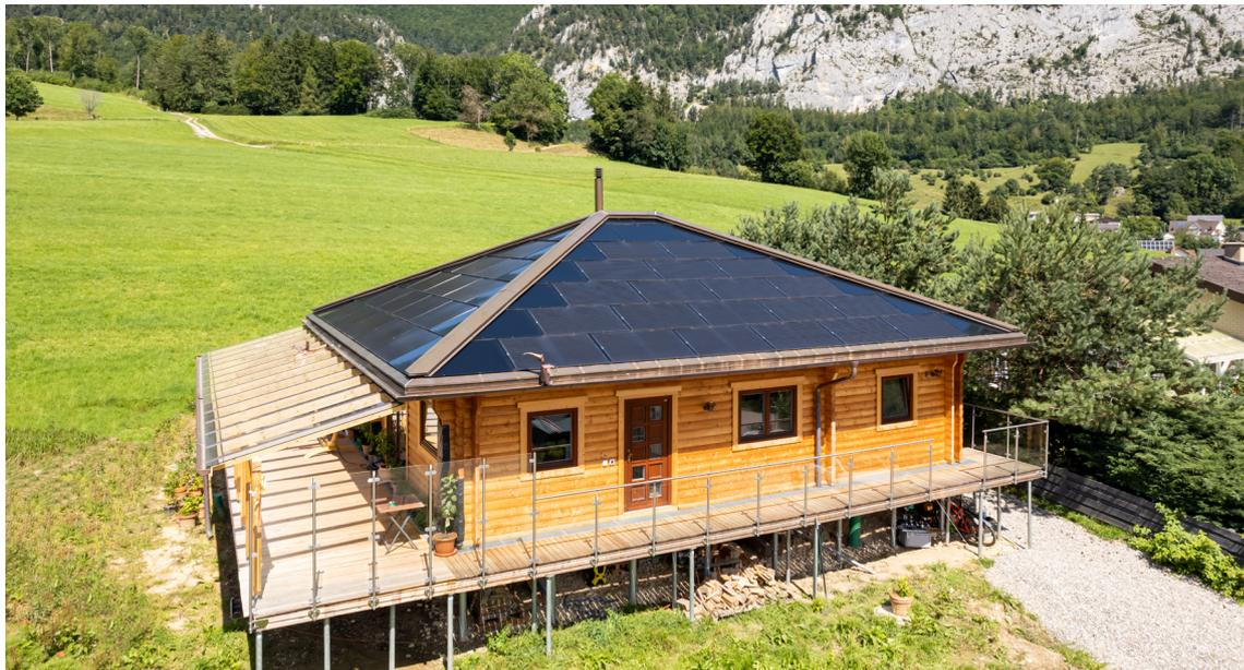
Abbildung 11: Schrägdach Indach PV, Einfamilienwohnhaus Welschenrohr Rötistrasse. Solstis ®
