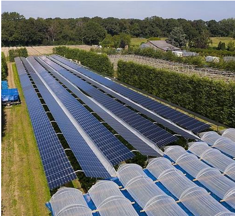
Himbeerfarm in den Niederlanden mit PV-Modulen statt Folientunneln. Bild: BayWa r.e / GroenLeven
