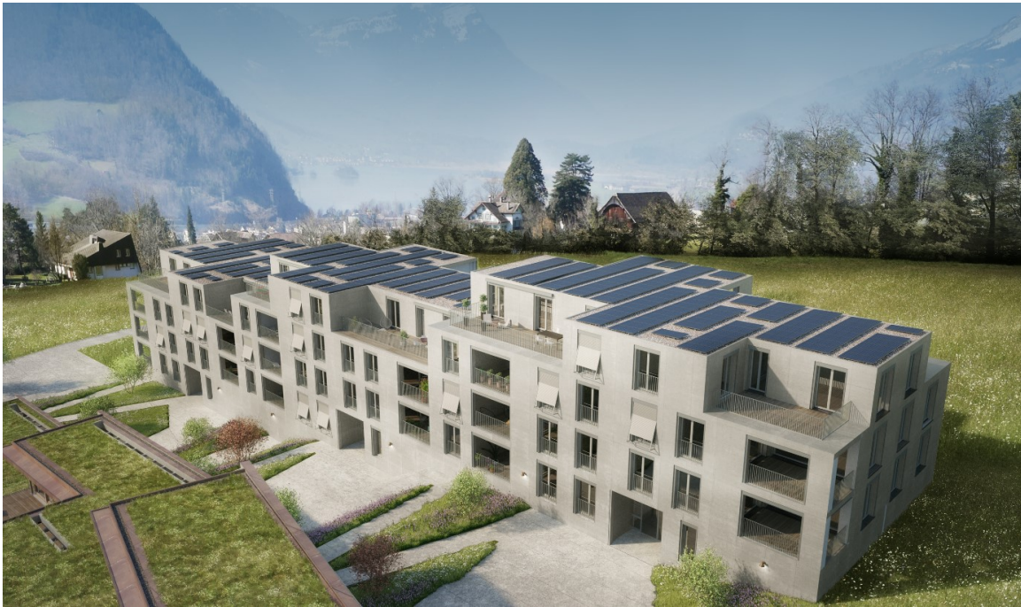
Illustration 16: quartier Mättivor, Schwyz: solution globale pour l'électricité et la mobilité avec batteries de stockage et bornes de recharges pour véhicules électriques reliées à l'automatisation du bâtiment, décomptée via un système de cloud intégré pour le contracting et fournie par ecocoach AG. Source de l'illustration: Cimag AG / nightnurse images
