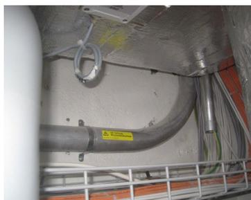
Linea DC del FV in canalina di alluminio completamente chiusa, inclusa marcatura.
