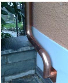
Linea DC del FV in tubo di protezione RF2 e in tubo di scolo in rame RF+ sulla facciata esterna
