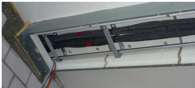
Canalina antincendio EI 60-RF1 con posa inevitabile lungo una via di fuga
