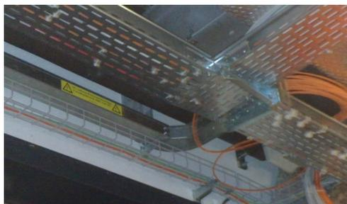
Linea principale DC in portacavi metallico completamente chiuso, compresa marcatura.
