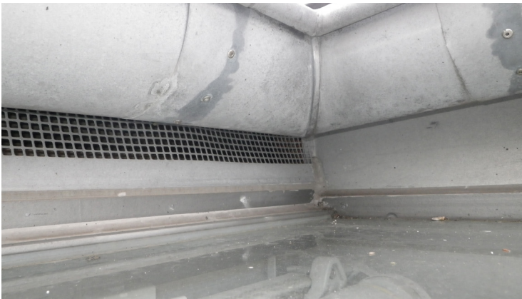
Exécution avec tôle perforée carrée
