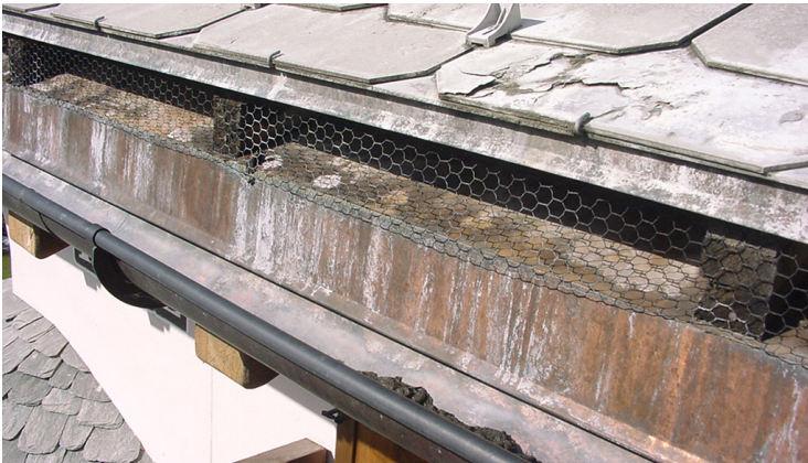
Exécution avec treillis métallique
