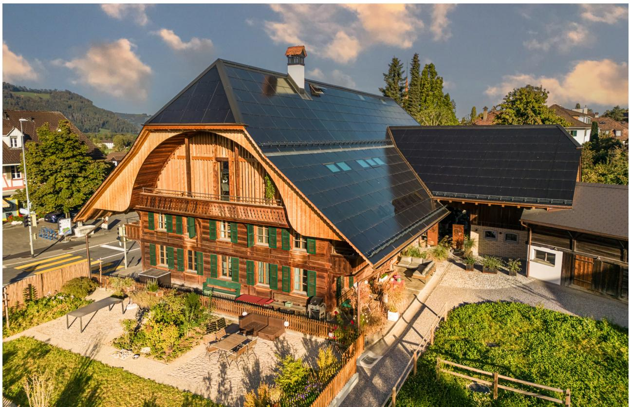
Das denkmalgeschützte MFH von 1813 erstrahlt nach der Sanierung mit der vorbildlich dachintegrierten 103 kWc starken PV-Anlage in neuem Glanz,
