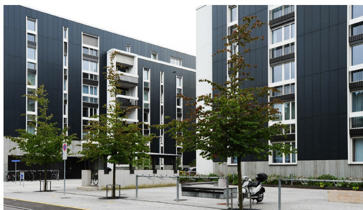
Solarfassade der Wohnüberbauung «Im Heuwinkel» in Allschwil BL mit einer Leistung von 75,1 kW, © Swissolar / Céline Kuster
