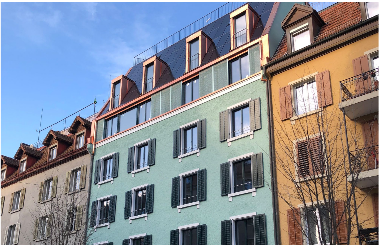
Sanierung und Aufstockung MFH Kofmel in Zürich/ZH, © Schweizer Solarpreis 2021 Beteiligtes Swissolar-Mitglied: Agrola AG (Solvatec) Assainissement et surélévation de l'immeuble d'habitation Kofmel à Zurich/ZH, © Prix solaire suisse 2021 Membre Swissolar participant : Agrola AG (Solvatec)
