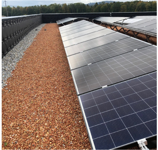
Figure 5: L'installation PV doit être installée à une distance suffisante des éléments de construction, raccords muraux, etc. attenants, source: Contec
