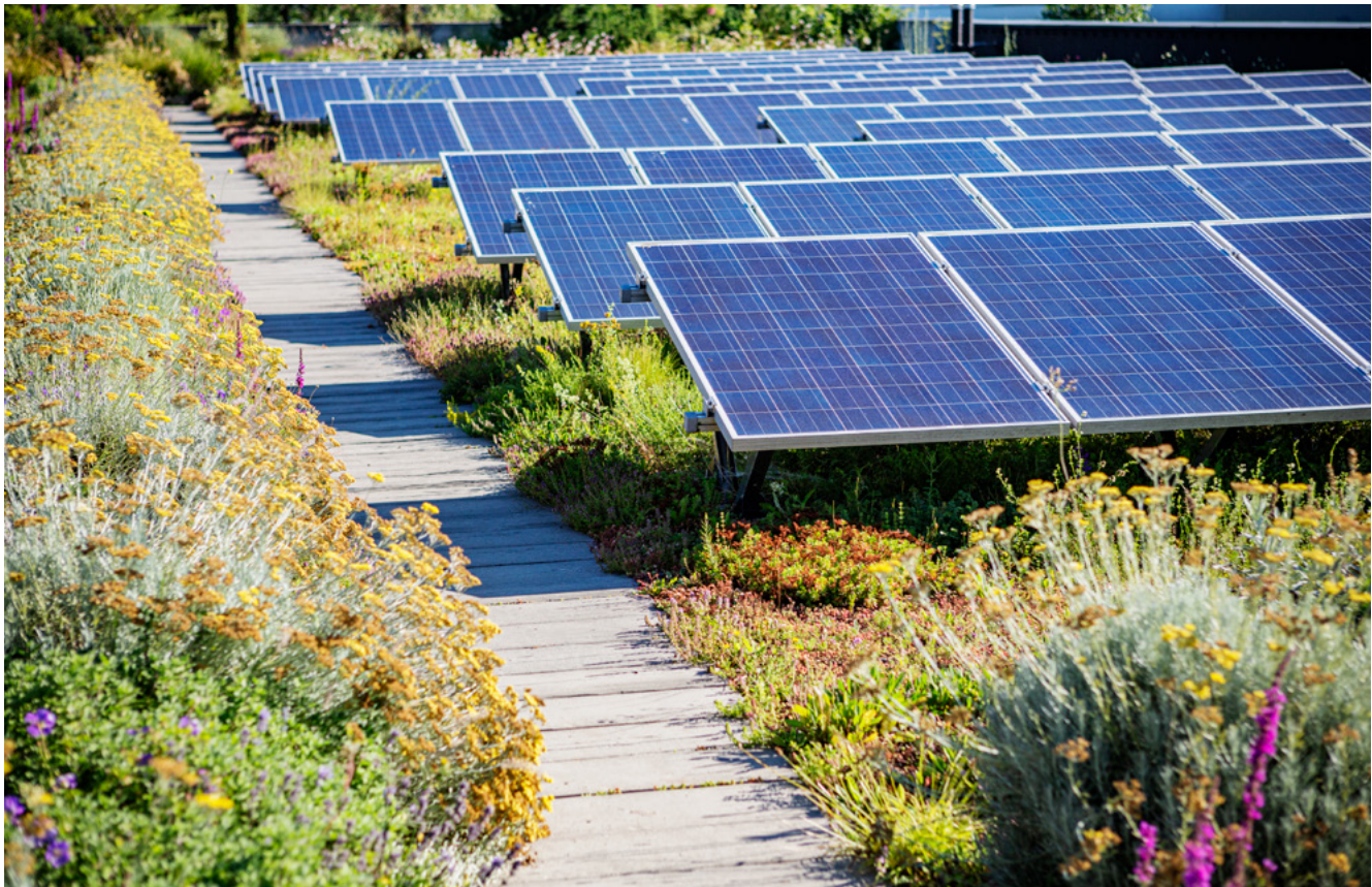
Figure 3: Combinaison d'une végétalisation intensive/extensive de la toiture à côté d'une installation PV, source: Contec
