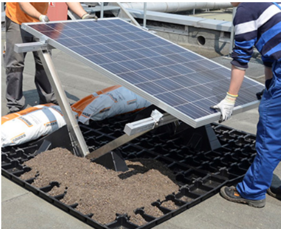
Figure 6: Système de lestage pour un cadre de montage de module PV, source: Bauder
