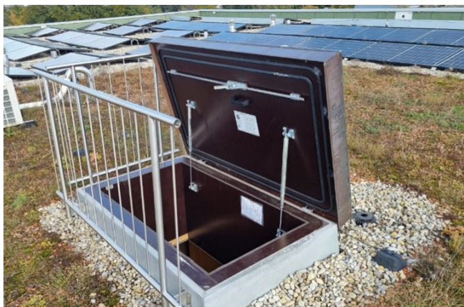
Figura 30: Casa di riposo e cura di Wienerberg, San Gallo. Fonte: Stadtwerke St. Gallen
