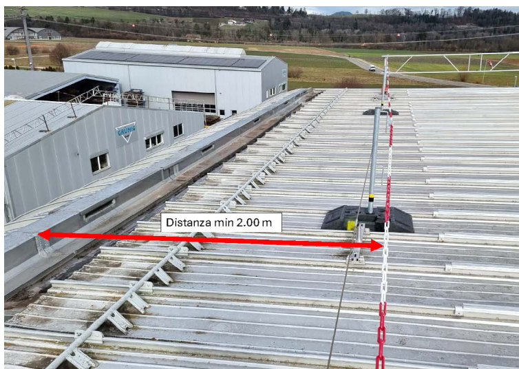
Figura 28: Sbarramento con catena. Fonte: Involucro edilizio Svizzera
