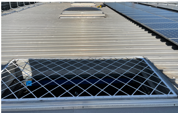
Figura 26: Lucernario a cupola con sistema di sicurezza sotto la calotta. Fonte: FPS Concept Sàrl
