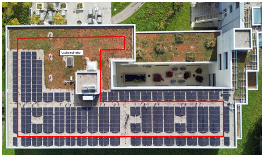
Figura 5: Casa di riposo e cura di Wienerberg, San Gallo, fotovoltaico e inverdimento separati. Fonte: Stadtwerke St. Gallen
