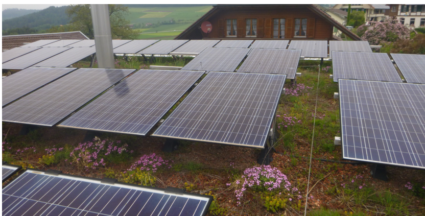
Figura 32: Tetto verde fotovoltaico e linea vita a fune. Fonte: Contec
