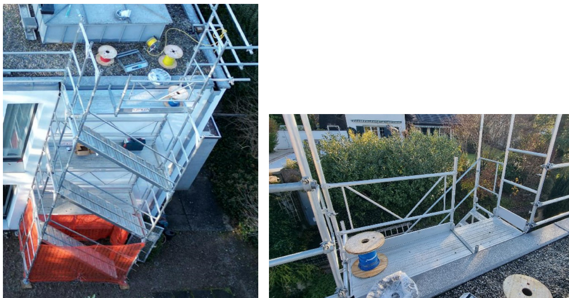
Figura 29: Accesso al luogo di lavoro per l'installazione di un impianto fotovoltaico tramite scala a torre. Fonte: Involucro edilizio Svizzera
