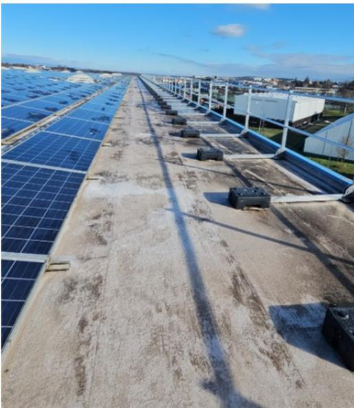
Figure 21 : Bord de toit sécurisé temporairement au moyen d'un garde-corps autoporté
