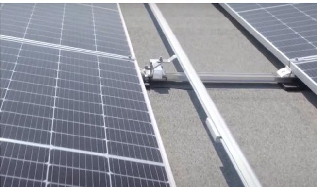
Figure 13 : INNOTECH TAURUS, système à rails sur une installation photovoltaïque
