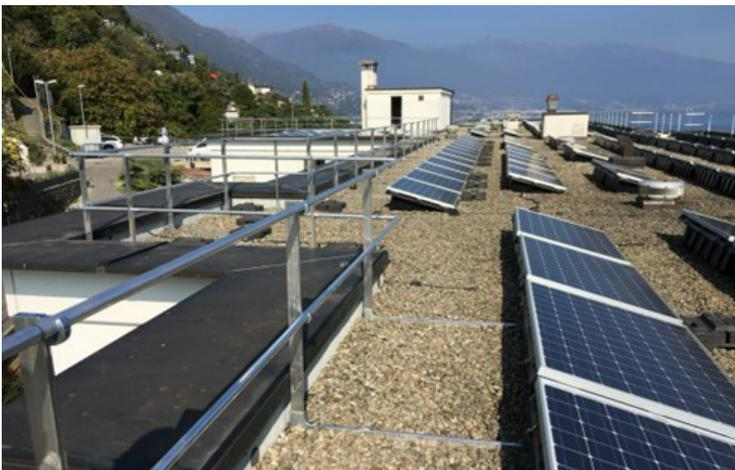
Figure 22 : Bord de toit sécurisé par un garde-corps permanent
