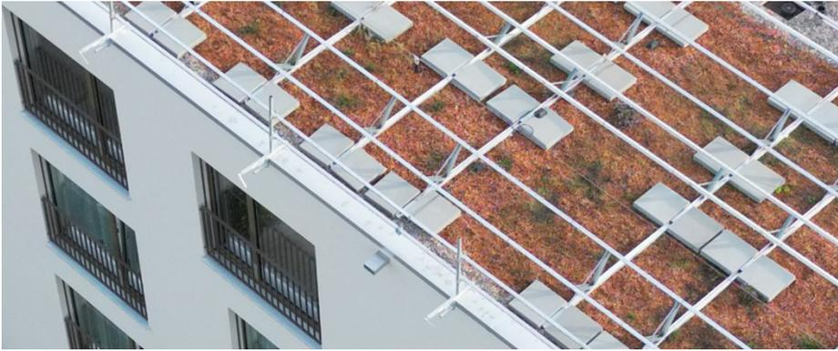
Figure 20 : Garde-corps en bordure fixé au bord du toit avec des consoles de serrage
