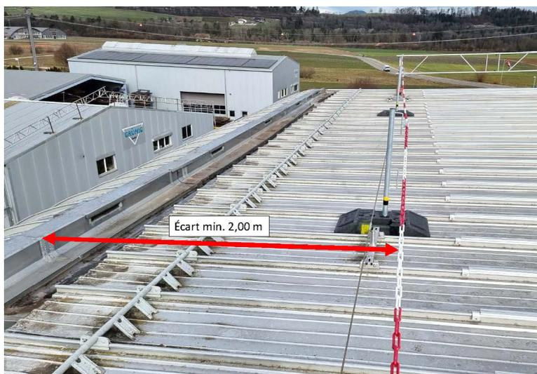
Figure 28 : Délimitation de zone avec une chaîne,
