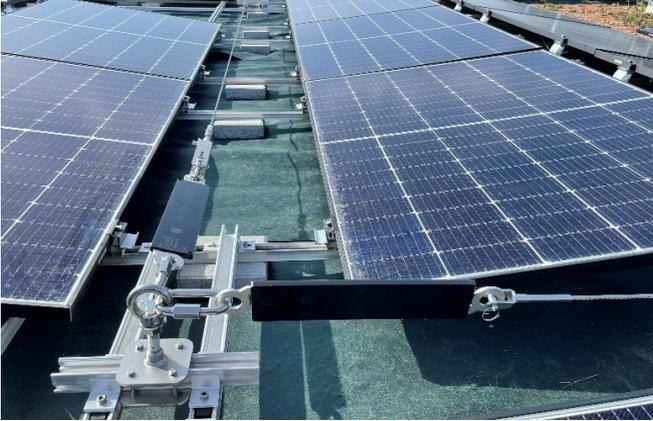
Figure 11 : ABS X-Lock Solar sur système K2 Dome
