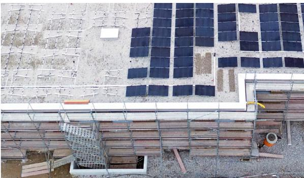
Figure 17 : Sécurisation du bord du toit au moyen d'un échafaudage de façade (classe de charge 3, 200 kg/m<sup>2</sup>), largeur du pont d'échafaudage min. 60 cm, hauteur du garde-corps au-dessus du bord supérieur du toit min. 80 cm
