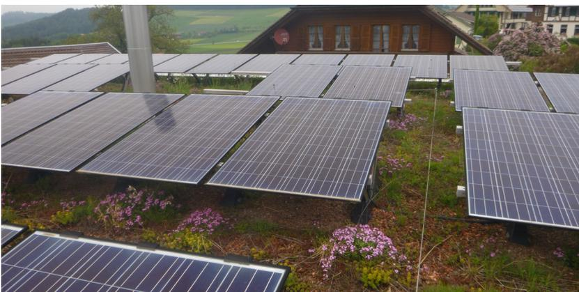
Abbildung 32: PV-Gründach und Seilsicherungssystem, Quelle: Contec
