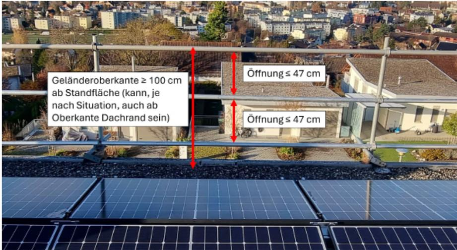
Abbildung 19: Dachrandgeländer mit Stahlrohr, Quelle: Gebäudehülle Schweiz
