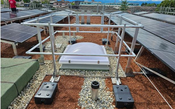
Abbildung 25: Permanente Sicherung Lichtkuppel/-band mit Geländer
