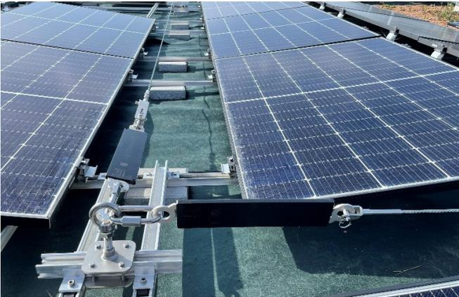
Abbildung 11: ABS X-Lock Solar auf K2-Dome-System
