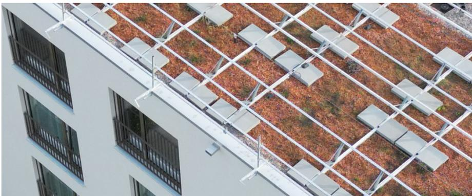
Abbildung 20: Dachrandgeländer mit Klemmkonsolen an Dachrand gesichert, Quelle: Gebäudehülle Schweiz
