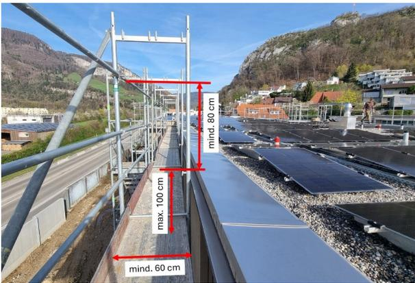
Abbildung 16: Fassadegerüst am Dachrand, hier Lastklasse 3, Nutzlast 200 kg/m<sup>2</sup>, nicht für Materiallagerung, bei Bedarf sind durch den Gerüstbauer Materialpodeste zu erstellen
