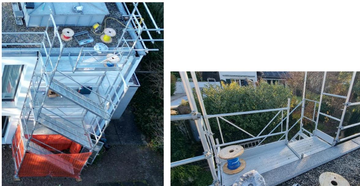
Abbildung 29: Arbeitsplatzzugang für PV-Montage mittels Treppenturm, Quelle: Gebäudehülle Schweiz
