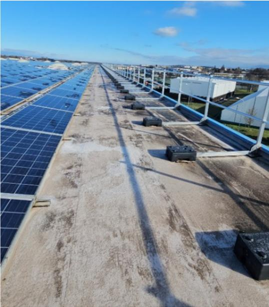
Abbildung 21: Dachrand temporär mittels Gegengewichtgeländer gesichert
