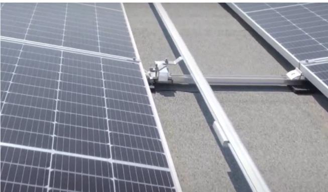
Abbildung 13: INNOTECH TAURUS, Schienensystem an PV-Anlage
