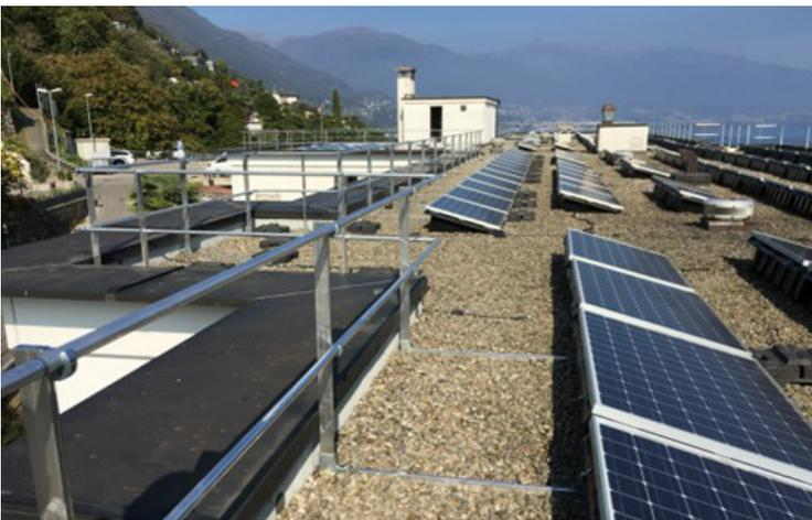
Abbildung 22: Dachrand mit permanentem Geländer gesichert
