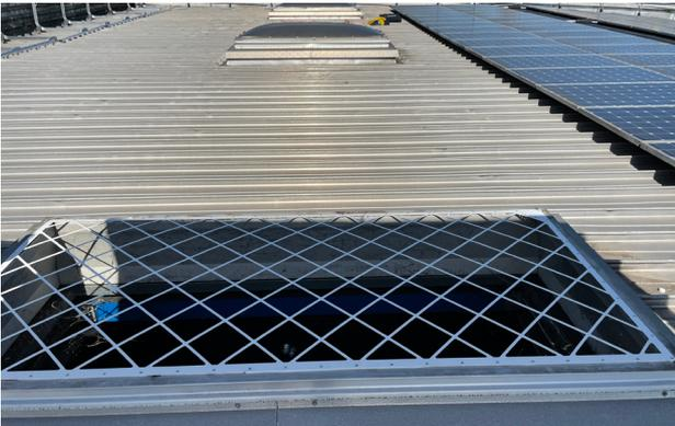
Abbildung 26: Lichtkuppel mit Sicherung unterhalb Schale
