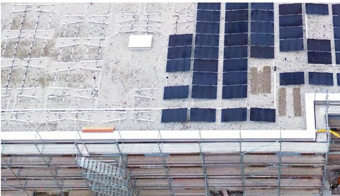
Abbildung 17: Sicherung Dachrand mittels Fassadegerüst (Lastklasse 3, 200 kg/m<sup>2</sup>), Gerüstgangbreite mindestens 60 cm, Geländerhöhe über Dachrandoberkante mindestens 80 cm
