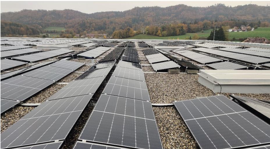
Abbildung 7: Grosse PV-Anlage mit Instandhaltungsgängen, Quelle: Migros
