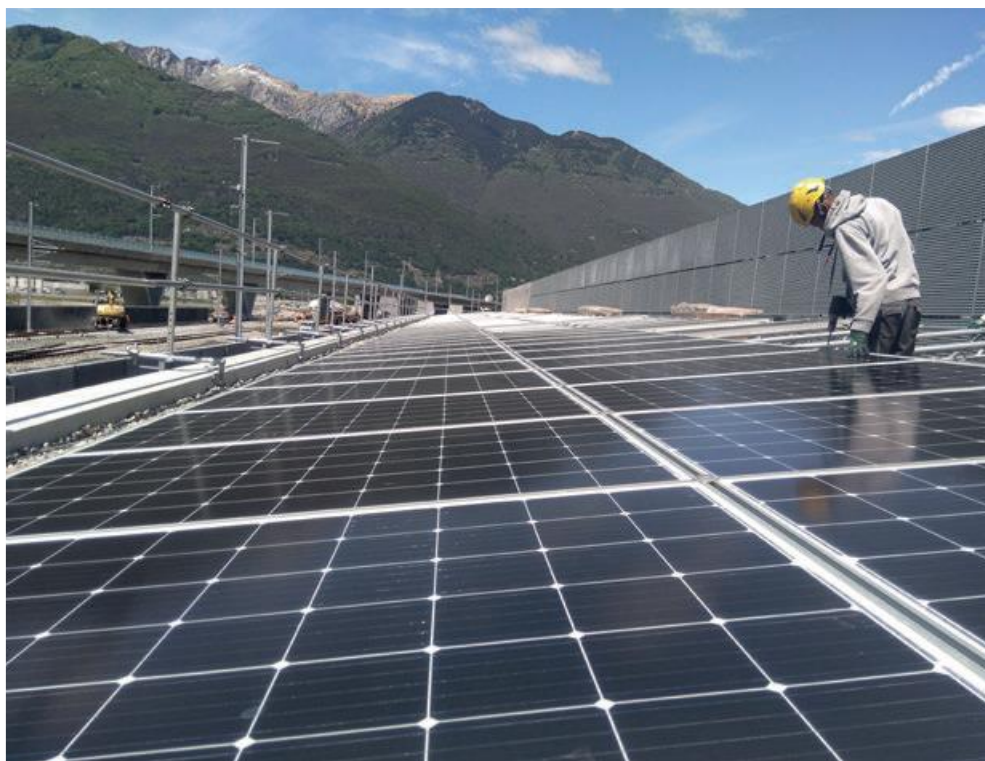
Figure 28 : bâtiment de technique ferroviaire de Camorino, photo : Evolve SA
