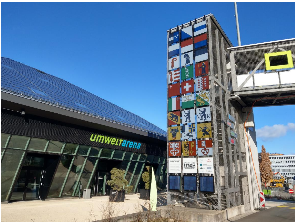
Figure 4 : modules PV imprimés en couleur à l'Umwelt Arena à Spreitenbach. Suivant les couleurs, les cellules solaires sont visibles en transparence, photo : Christof Bucher, Basler & Hofmann
