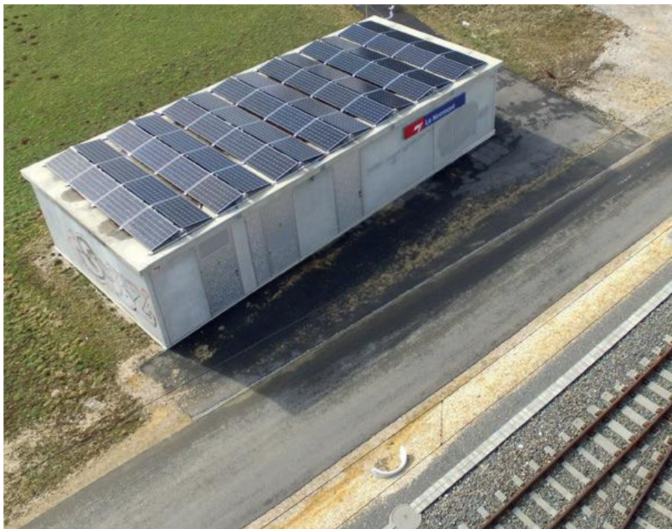
Figure 12 : bâtiments de technique ferroviaire au Noirmont, photo : Société des Forces Électriques de La Goule SA
