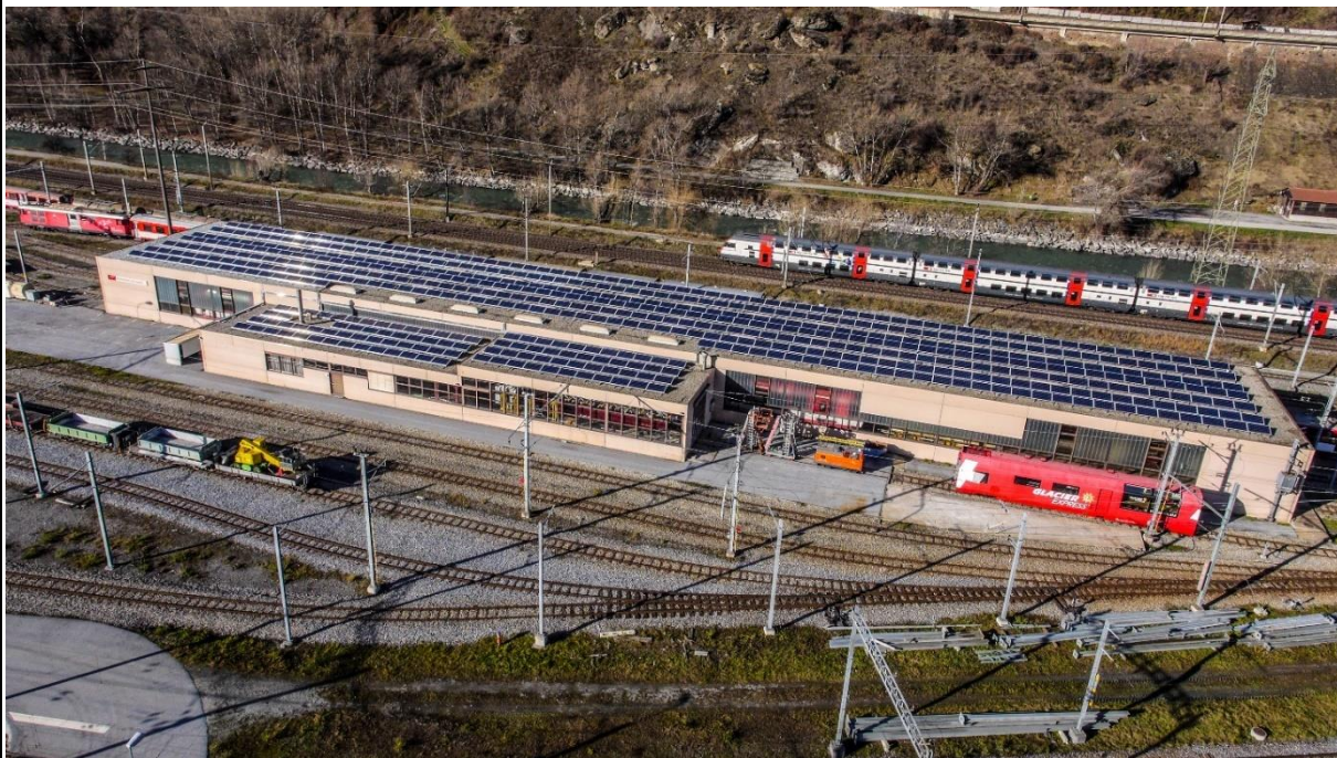
Figure 43 : toit du dépôt MGB de Gamsen (est), avec installation PV, photo : EnAlpin
