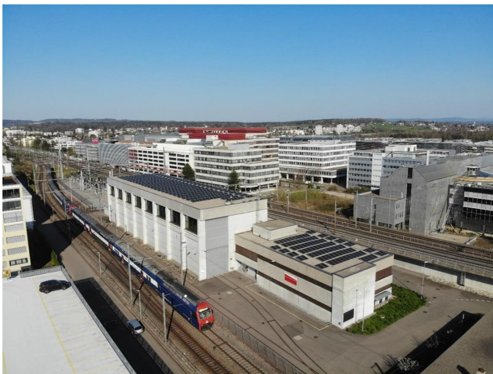
Figure 13 : poste de conversion de fréquence avec installation PV à Zurich-Seebach, photo : Christof Bucher
