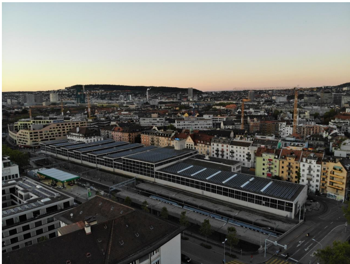
Figure 30 : nouvelle installation PV sur le toit du dépôt de trams de l'Elisabethenstrasse, photo : Basler & Hofmann AG, Christof Bucher
