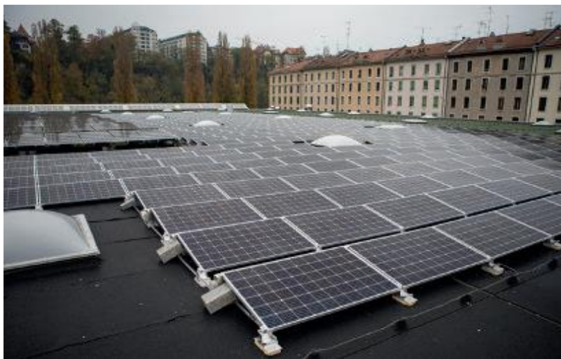
Figure 11 : toit du dépôt de la Jonction, photo : Pierre Albouy
