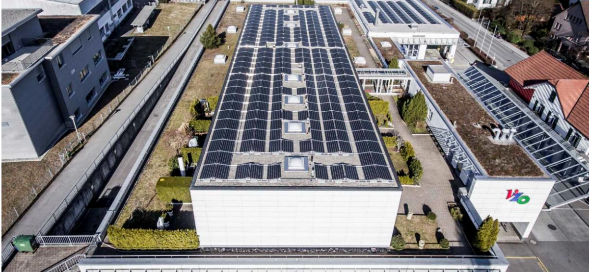
Figure 40 : toit du garage de bus de Grüningen, photo : VZO, Christian Merz Fotografie
