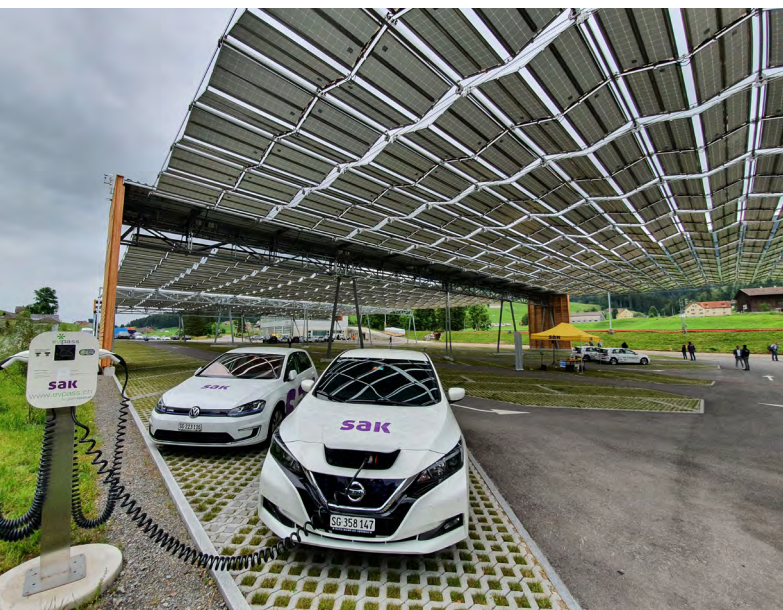
Photo : St. Gallisch-Appenzellische Kraftwerke AG (SAK)
