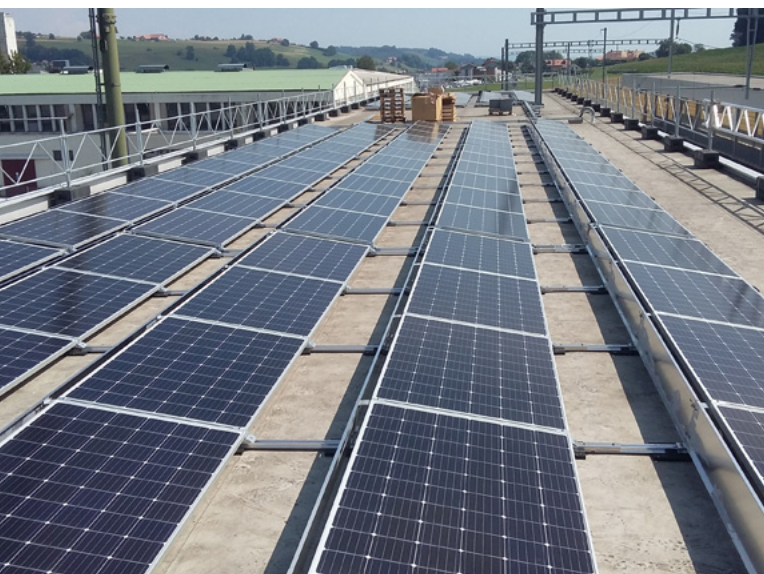
Gare de Belfaux (FR) Photo : Julien Horner, TPF
