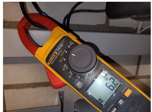
Abbildung 2: Überprüfung Funktion Messgerät, Swissolar
