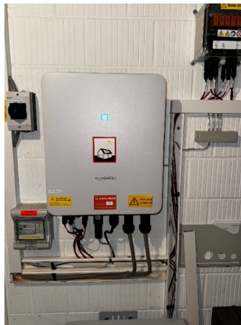
Figura 2: Vista con canaline aperte, ASCE
