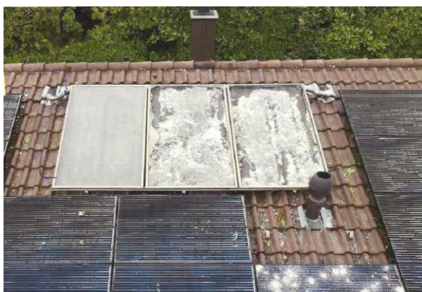
Figura 2: Impianto fotovoltaico e impianto solare termico danneggiati dalla grandine. Immagine: Ernst Schweizer AG
