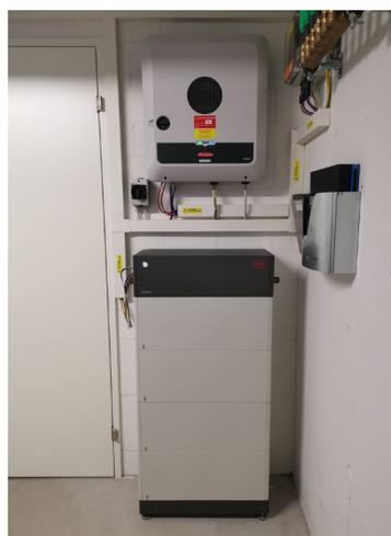
Figura 1: Impianto fotovoltaico con sistema di accumulo ibrido in corrente continua in una casa unifamiliare (MF) (fonte: BS Strohmeier AG)
