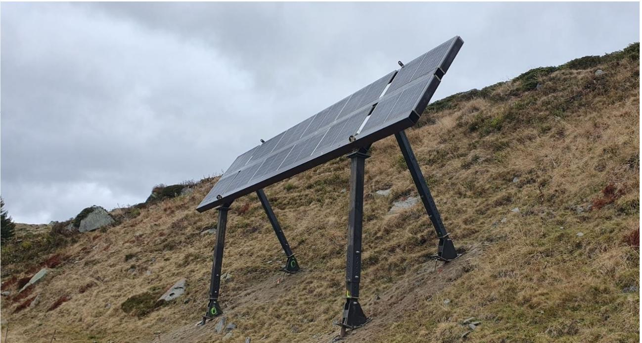
Abbildung 10: Testanlage NalpSolar nach Design von Basler & Hofmann AG. Version für steiles Gelände mit erhöhter Belastung. Abbildung von Axpo AG
