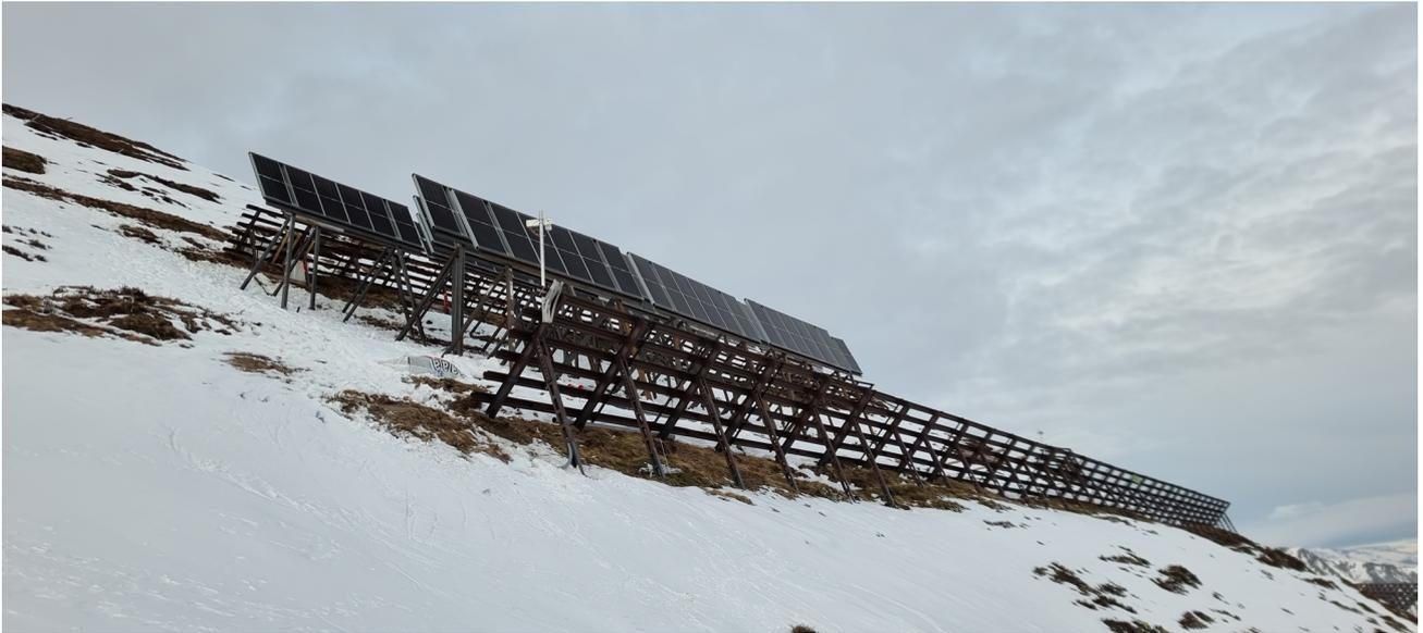
Abbildung 12: Erste 20 Modultische der Sedrun Solar mit bifazialen Glas-Glas-Modulen (108 und 144 Halbzellen). Abbildung von Sedrun Solar AG, ZENDRA AG (November 2024)
