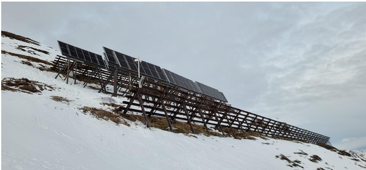
Abbildung 19: ALPIN QUATTRO® Generation 4: Vorinstallation von 20 ALPIN QUATTRO® Tischen im Projekt SedrunSolar. Abbildung von Sedrun Solar AG, ZENDRAAG (Dezember 2024)
