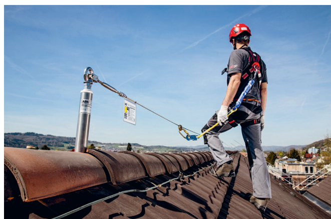
Fig. 5: Classe d'équipement 2; ligne de vie
