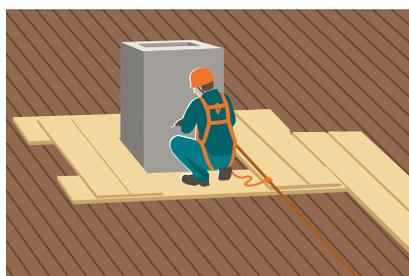
**2** Postazione di lavoro resistente alla rottura con piano di calpestio formato da tavole e ulteriore DPI anticaduta (vedi regola 8)
