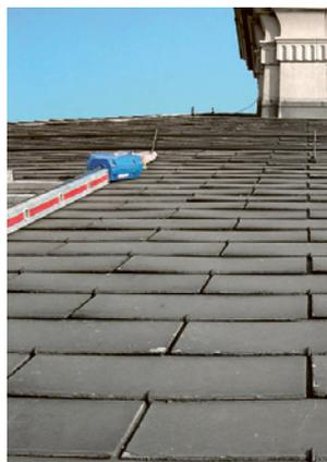
2 Tetto con lastre in fibrocemento contenenti amianto
