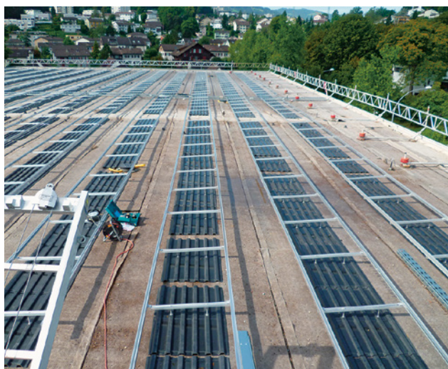
2 Montaggio di un impianto solare con protezione laterale temporanea al bordo del tetto
