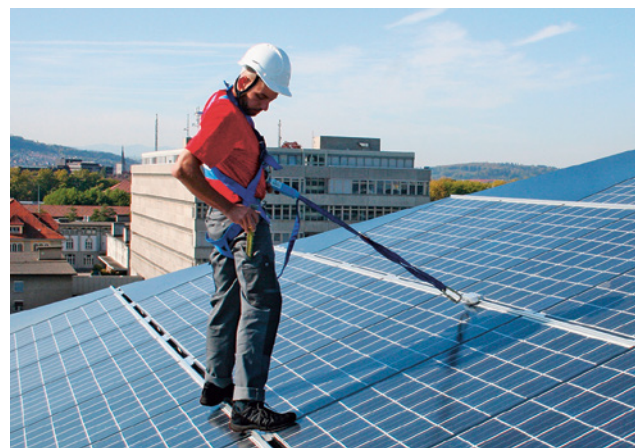
12 Dispositivo di ancoraggio integrato nell'impianto solare
