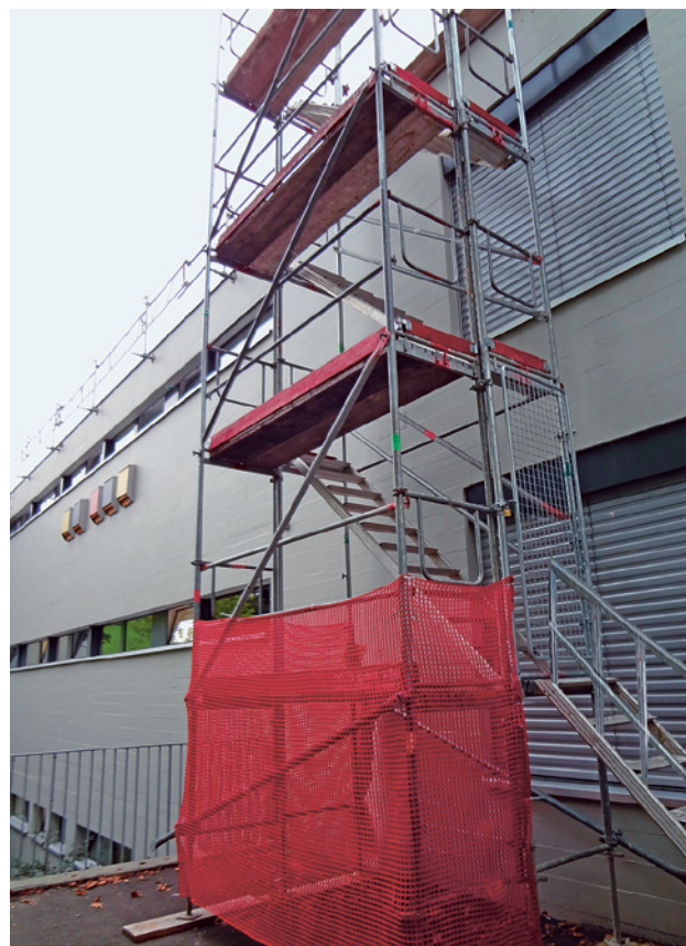
3 Accesso sicuro tramite una torre scala (ponteggio)
