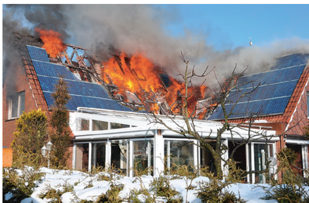
20 Incendio in un edificio con impianto solare
