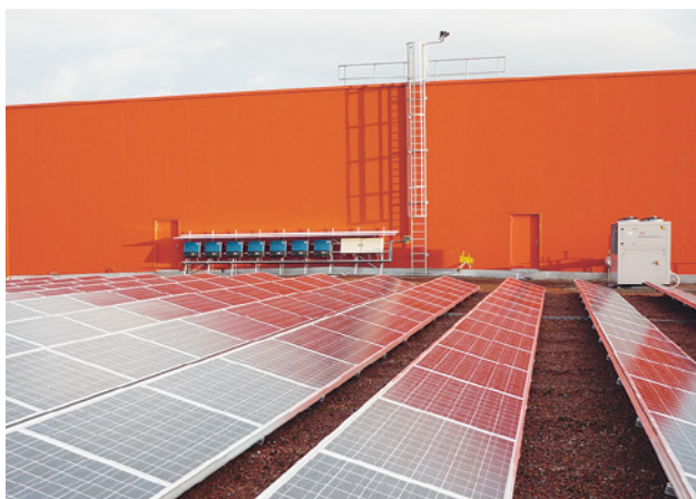
11 Scala a pioli fissa con gabbia di protezione dorsale
