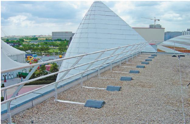
6 Garde-corps sans fixation à la toiture, pour une utilisation temporaire ou permanente
