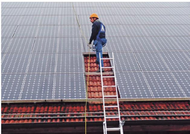
18 Corde lancée par-dessus la toiture, assurée par un antichute mobile
