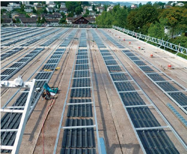
2 Montage d'une installation solaire avec protection latérale temporaire sur le bord du toit
