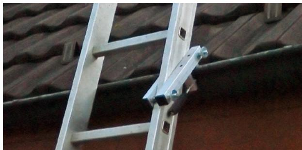
19 Accès sûr au toit pour les travaux de courte durée; échelle assurée sur le bord du toit
