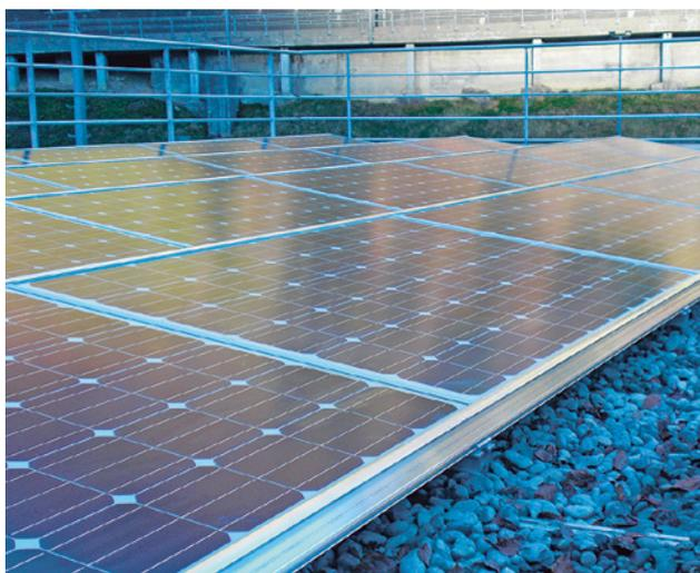
4 Installation solaire sur un toit plat avec garde-corps permanent sur le pourtour
