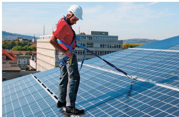
12 Système d'ancrage intégré dans l'installation solaire
