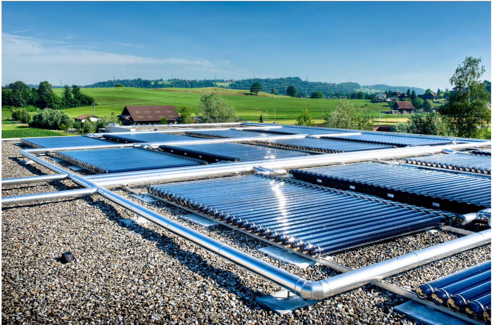
Kerzenfabrik Root LU - 128m 2 Röhrenkollektoren DF6 von Augusta Solar
